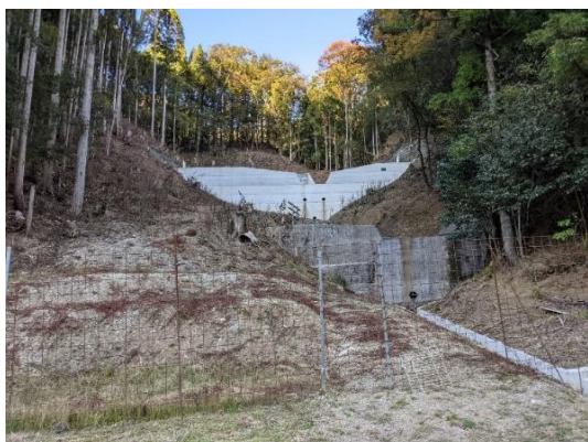
<治山事業（佐用郡佐用町多賀地内）①>
