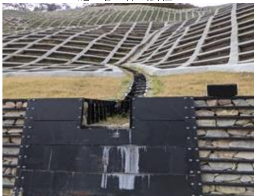
<令和2年度（2補緊第1号）治山事業> 施工者 株式会社A
